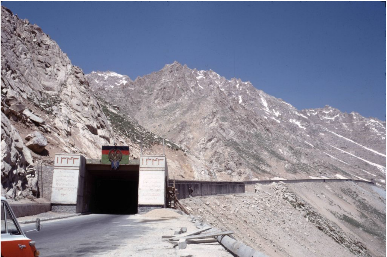
Der 2,5 km lange Salang-Tunnel wurde der Sowjetunion gebaut und verbindet den Norden Afghanistans mit Kabul und den südlichen Regionen. Auf diesem Foto von 1975 hängt ein Porträt von Daoud über dem Eingang.
